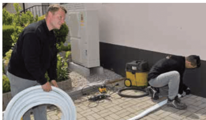
За свързването на модулите на термopомпата е необходим само малък отвор в стената
