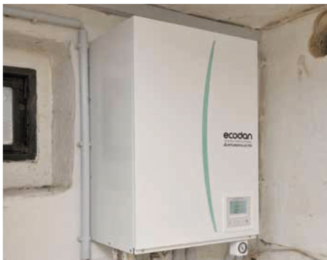
Хидромодулът осигурява ефективен пренос на енергия от хладилния агент към водата за отопление
